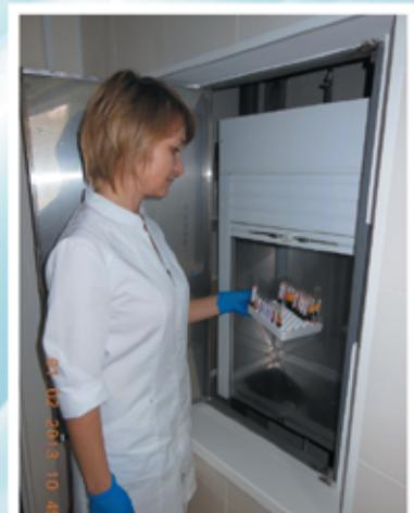
После встречи с курьером лабораторные техники сортируют три - четыре штатива с пробирками и разносят их по отделам. Пробирки поднимаются на исследования в специальном лифте, что связано с соблюдением правил безопасности при работе с патогенными биологическими агентами, необходимостью обеспечить разделение так называемых «чистых» и «грязных» потоков.
